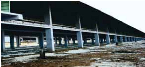
चित्र 2.2.1 ऊपर उठा कर निर्माण किया हुआ पोल्ट्री घर
